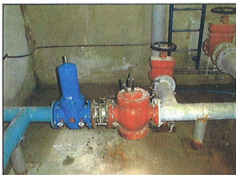
[Figura 3] Válvula de flotador Ross con reductora previa.
