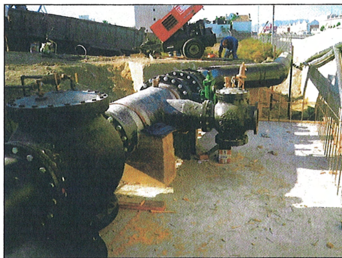
[Figura 2] Instalación de válvula reductora y válvula de alivio Ross .
