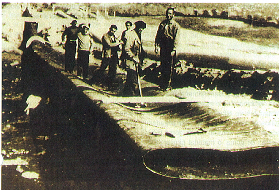
Foto 1. Aplastamiento de una tubería por falta de ventosas que permitieran la entrada de aire durante su vaciado.
